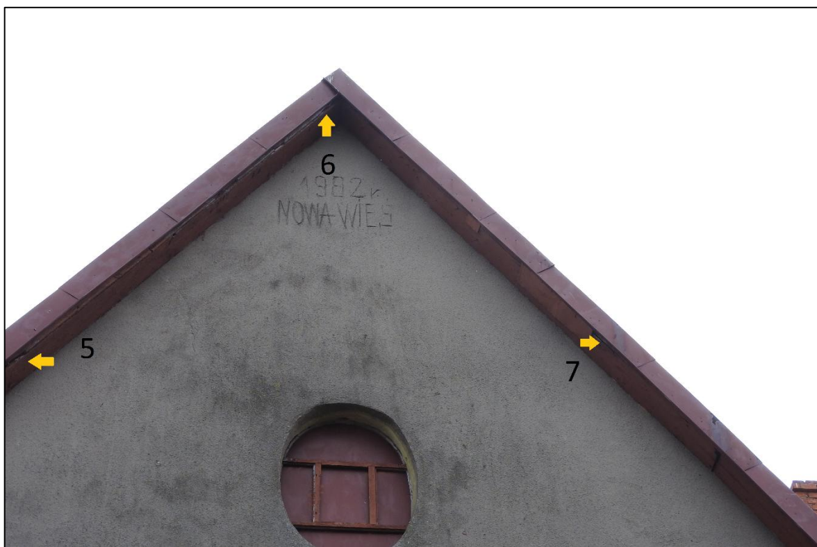
Fot.2. Zbliżenie fragmentu elewacji północno zachodniej z zaznaczonymi szparami wlotowymi pod wiatrownice (5-7).
