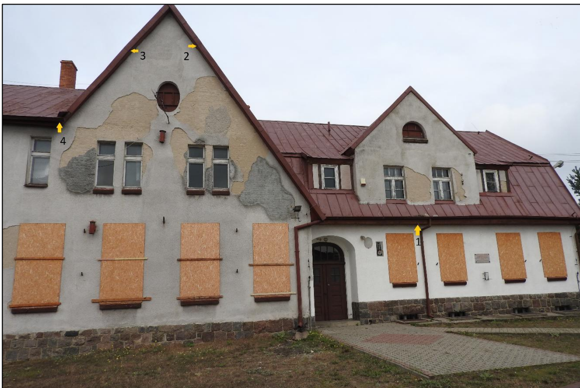
Fot. 1. Widok elewacji południowo – wschodniej budynku szkoły z zaznaczonymi wlotami pod wiatrownicę (1-4).
