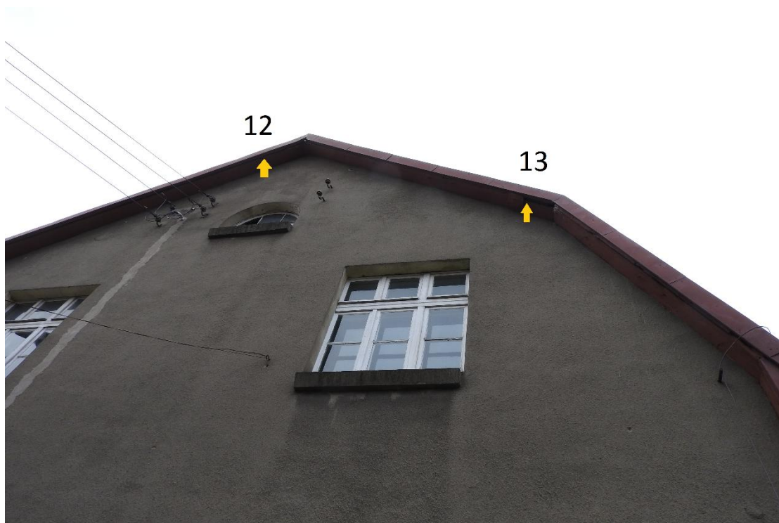
Fot. 8. Wloty pod wiatrownice na elewacji północno – wschodniej
