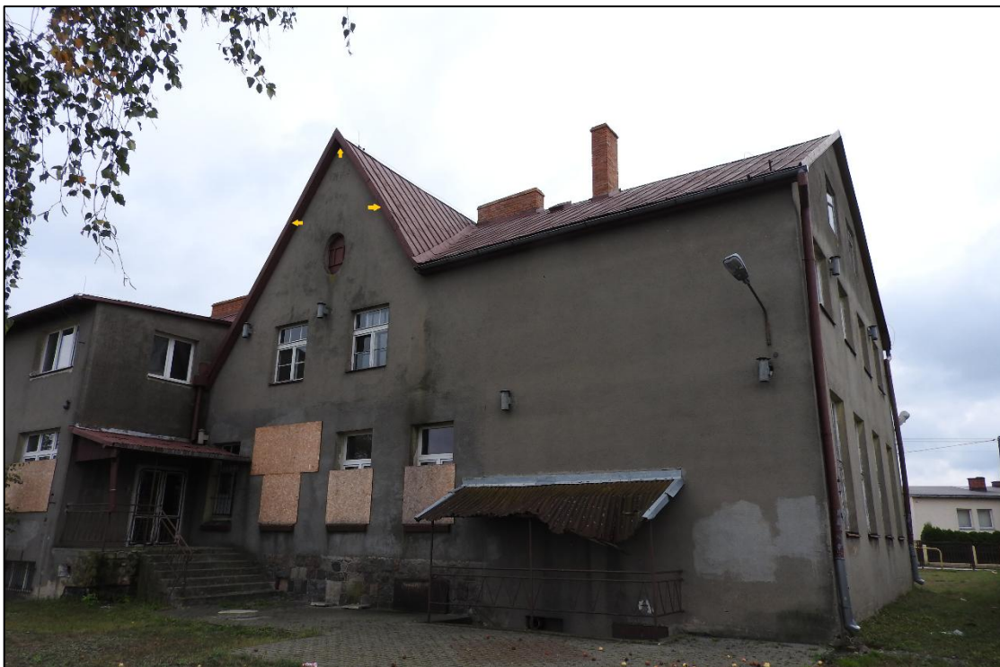
Fot.3. Widok elewacji północno – zachodniej z zaznaczonymi wlotami pod wiatrownicę (5-7).
